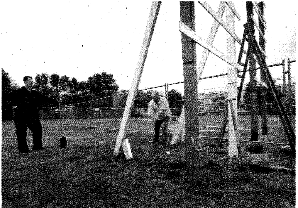
Bouwboarden worden de grond in geslagen aan de Eendrachtstraat.
